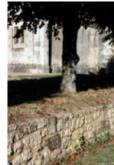
Muret de soutènement en moellons de pierre, tilleul
