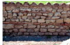
Mur de moellons de pierre, tuiles et briques
