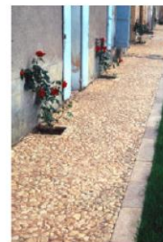
Béton et pierre calcaire
