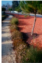
Surface en tuiles concassées et aménagement paysager
