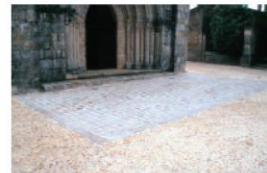
Parvis en pierre, espace public en béton coloré et pierre calcaire
