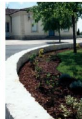
Muret en moellons de pierre pour protéger l'espace public
