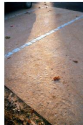
Parking en béton de calcaire désactivé
