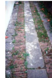
Pierres et briques posées sur chant
