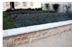
Muret en moellons et couronnement en pierre
