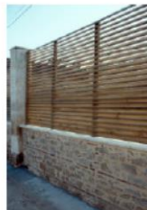
Mur restauré (pierre et brique) et claustra de bois
