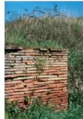
Soutènement en briques pleines
