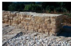
Muret en moellons de pierre
