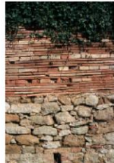
Moellons de pierre et briques pleines
