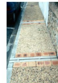
Béton de gravillons désactivé et carreaux de terre cuite
