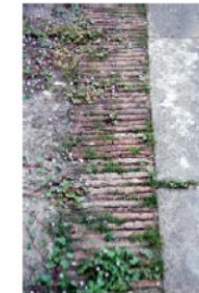
Pierres et briques posées sur chant
