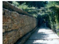
Mur en gabions de pierre
